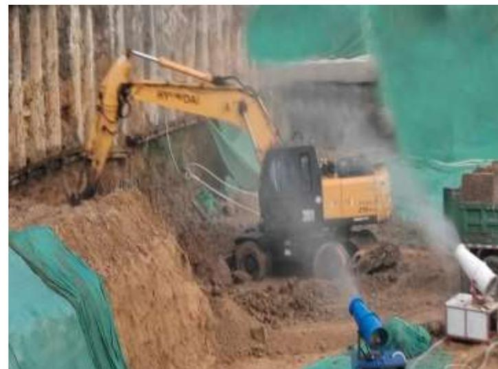
★土方施工作业过程中，合理控制土方开挖和存留时间；留存时间不得超过8小时。
