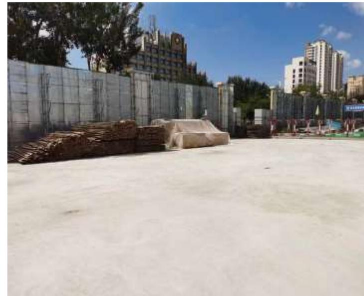
★各类加工区全部采用混凝土硬化设置，如无法进行混凝土硬化设置的，需要在材料堆放区设置混凝土定型块或者铺设钢板垫底，避免裸土外露。
