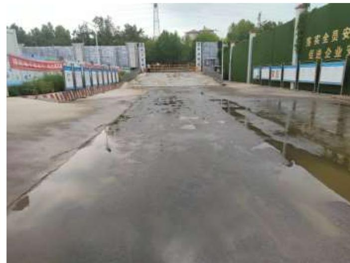
★施工现场道路及材料加工区地面必须进行硬化处理，路面要平整坚实。硬化处理是指使用硬化材料铺装，如：混凝土、混凝土预制块、铺装砌块、钢板等。
