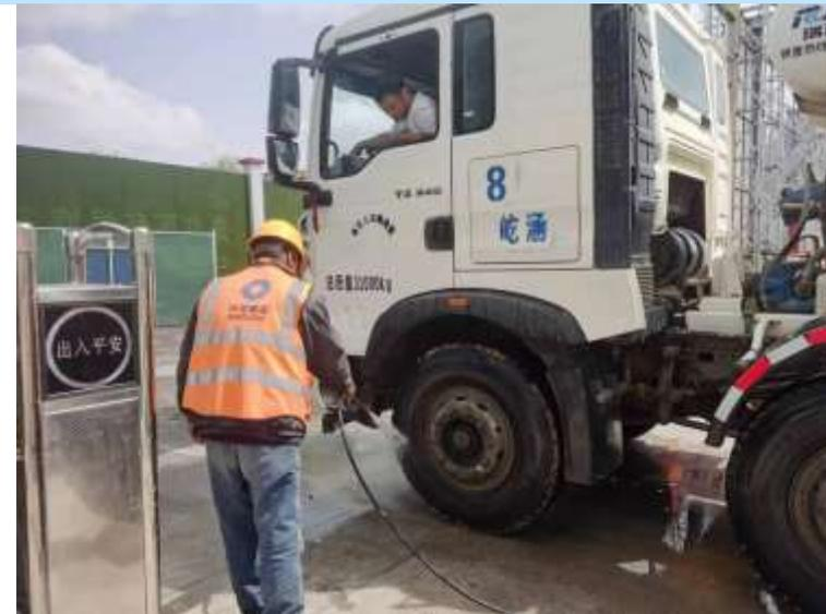
★为杜绝车辆带泥上路，按照“3+2”车辆冲洗管控要求（“3”即“漫水槽水洗+冲洗装置喷淋+人工高压水枪找补”的一体化冲洗流程；“2”即车辆出入口需安装实时视频监控系统并与监管部门联网，监控录像保存时长30天以上；工地周边道路常态化清扫保洁），确保车轮及车身冲洗到位，不得有带泥上路及渣土遗撒隐患。
