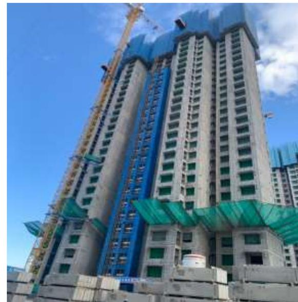
★加强高空扬尘的防治，建筑工程主体外窗口应全部采用防尘网封闭，并对防尘网进行定期冲洗或更换，防止破损积尘，造成二次扬尘污染。
