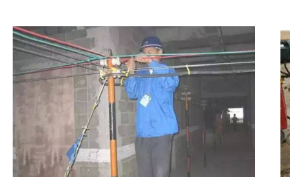
电缆线架空保护 (✓)
