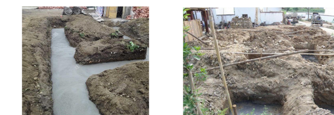
基坑及时用混凝土封底 (✓)
