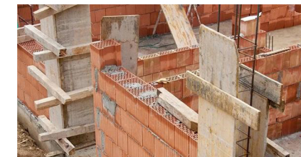
砌体结构、砖混结构应先砌墙后浇柱 (✓)
