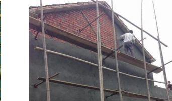
单排支撑、无剪刀撑 (✗)
