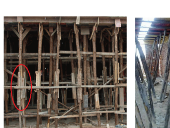
立杆接长采用对接夹板接头 (✓)
