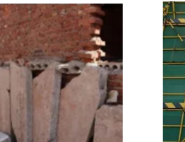
预制板质量不合格，断裂 (✗)
