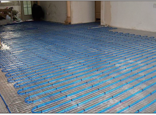
发热电缆布置方式
