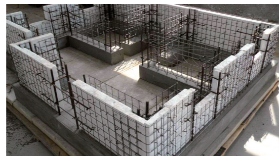
钢筋网架复合剪力墙结构
