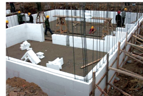
适用于低层建筑的EPS模块剪力墙体系
