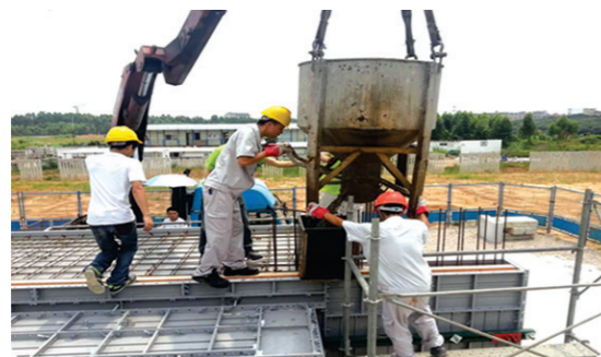
现场浇筑施工
