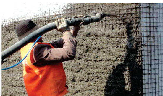
现场喷涂施工
