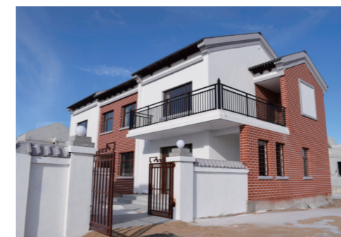
装配式混凝土墙板结构
