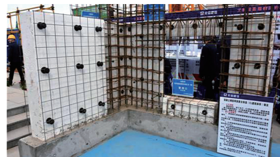
钢筋网架复合剪力墙结构体系
