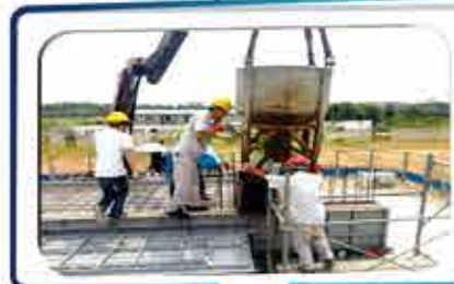
现场浇筑施工
