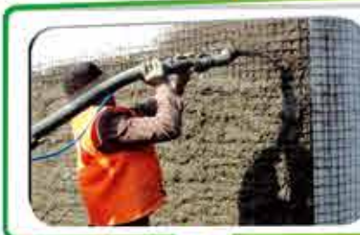
现场喷涂施工
